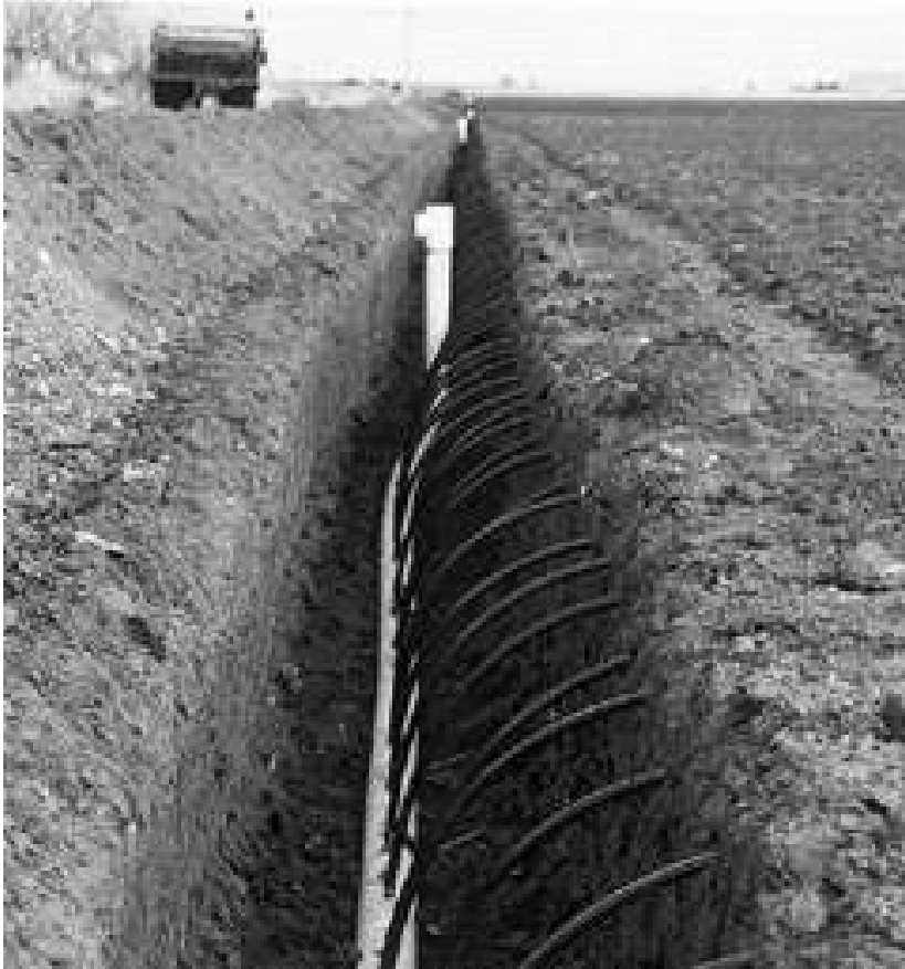
Instalación de riego por goteo subterráneo
