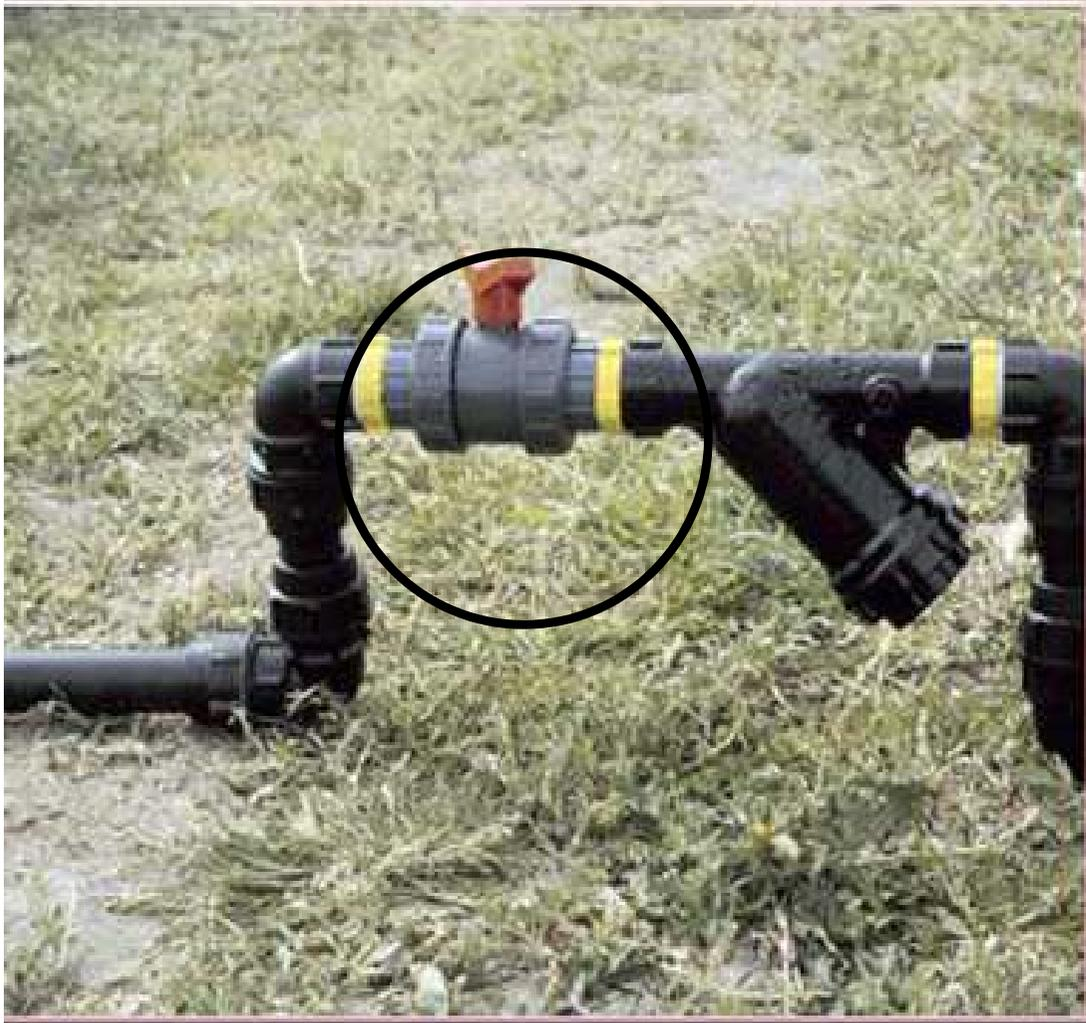
La bola taladrada permite abrir o cerrar el paso de agua en la conducción
